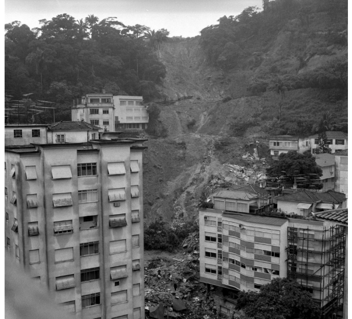
Deslizamento que deixou 119 mortos em Laranjeiras em 1967
