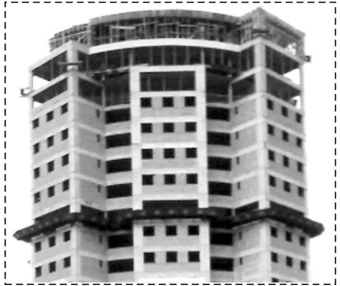
A foto mostra uma obra ainda em fase de elevação de alvenaria e finalização da estrutura. No detalhe da foto, aparece a parte superior do edifício. Trata-se de um edifício de apartamentos construído em estrutura de concreto armado e alvenaria comum de blocos cerâmicos vazados não-estruturais. A inclinação do edifício é apenas aparente, pois a foto foi tirada em ângulo desfavorável.
