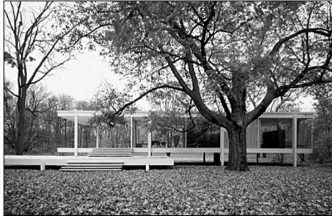
Vista do acesso
