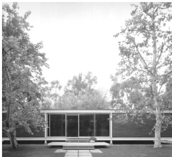
Vista do acesso
