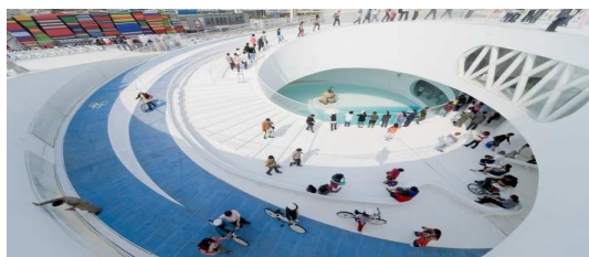
Figura 20 - Vista superior em perspectiva do Pavilhão da Dinamarca na Expo Xangai de 2010. BIG. Disponível em: www.concursosdeprojeto.org/2010 . Acesso em: 10 set. 2015
