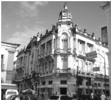
III - Prédio da Associação dos Empregados do Comércio da Bahia (Salvador)
