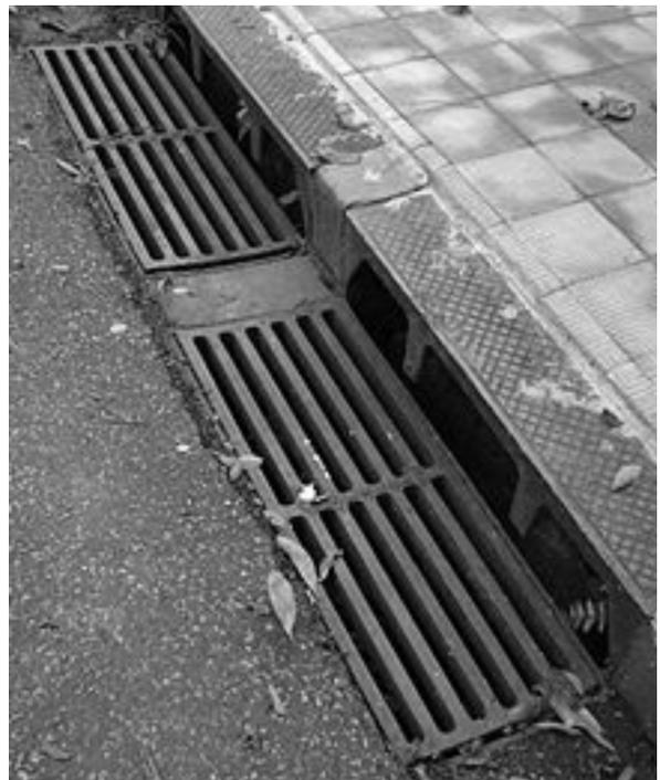
Observa-se nessa imagem um dos dispositivos recomendados pelo Manual de Drenagem de Rodovias do DNIT (2006) para o sistema de drenagem de transposição urbana de águas pluviais, que têm a finalidade de captar as águas pluviais que escoam pelas sarjetas para, em seguida, conduzi-las às galerias subterrâneas. Esse dispositivo é denominado:
