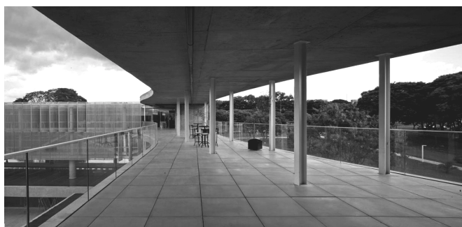
Vista do interior da varanda
