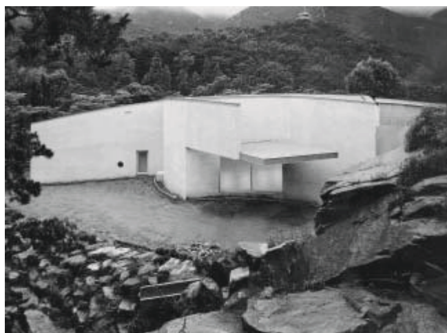
Pavilhão Anyang Coreia do Sul (2005-06)
