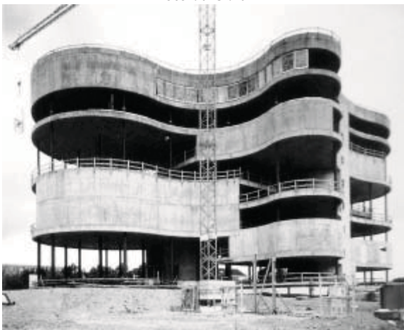
Foto da Obra
