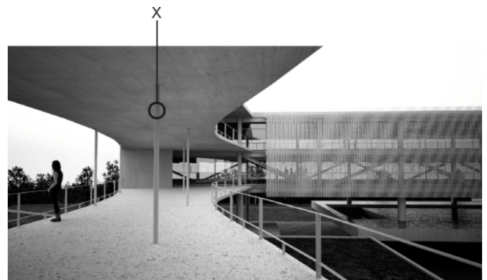
Figura 05 - SEBRAE Vista da Passarela
